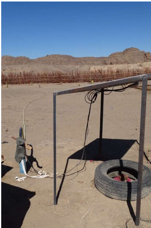
Abb. 17: Das Bohrloch von Surdodge mit hineingehängter Tauchpumpe und Solarpanels. Man erkennt das schwarze Hartplastikrohr an der Oberkante des Brunnenrohrs, um den Pumpenschlauch gegen Abknicken zu sichern. Im Hintergrund eine frisch angelegte Dattelpflanzung. März 2022.
