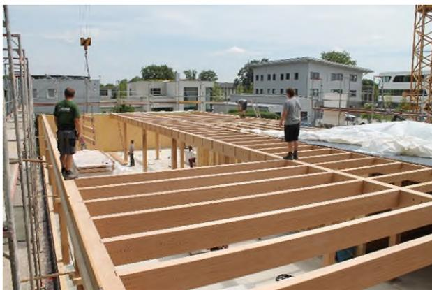
Abb. 11: Langfristige Verwendung von Laubholz im Gebäudesektor z.B. mit Buchenfurnierschichtholz. Bild: Lattkearchitekten.de
